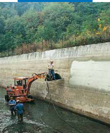
Strojno nanošenje Planiseal-a 88 u hidrotehničkom kanalu
