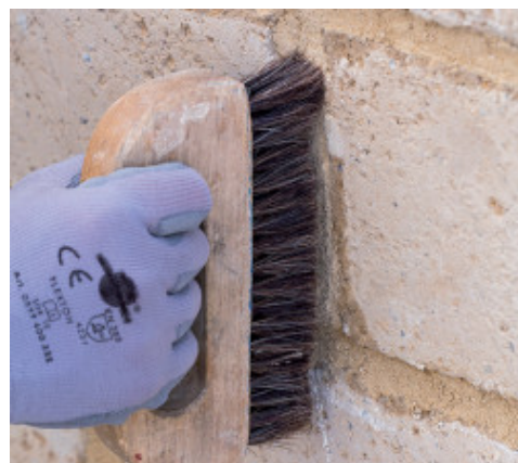
Završna obrada fuga
