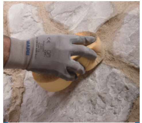
Završna obrada površine spužvom
