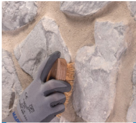
Završna obrada čeličnom četkom
