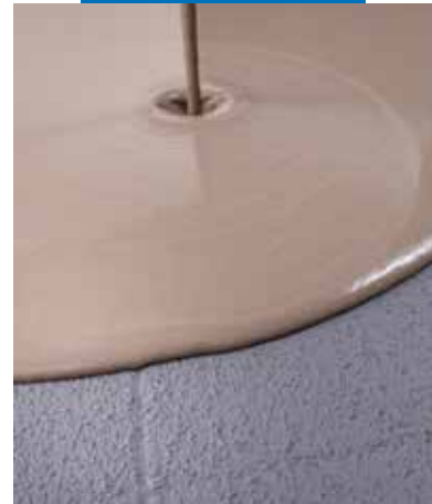
Nanošenje samorazljevne mase za zaglađivanje na suhi Eco Prim Grip Plus na postojećem podu
