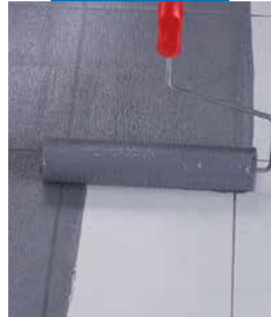
Nanošenje premaza Eco Prim Grip Plus valjkom na postojeće porculanske pločice
