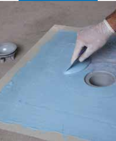
Nanošenje Mapelast ic -a AquaDefense na manžetu odvoda Drain Vertical
