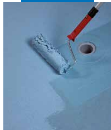
Nanošenje drugog sloja Mapelastic AquaDefense valjkom
