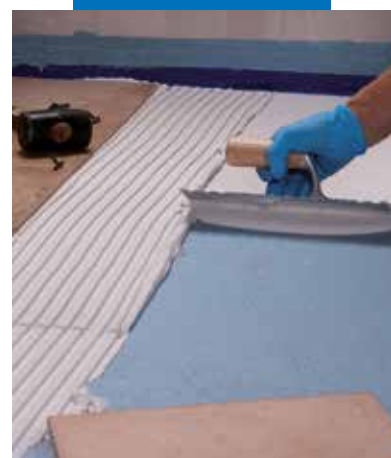
Polaganje keramičkih pločica na Mapelastic AquaDefense
