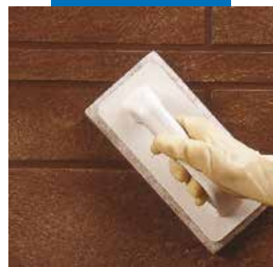
Čišćenje fuga Scotch-Brite® spužvom (proizvod djelomično veza)
