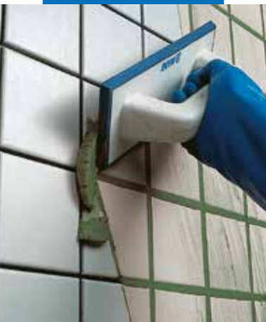
Nanošenje Ultracolor-a Plus na zid gumiranom gladilicom
