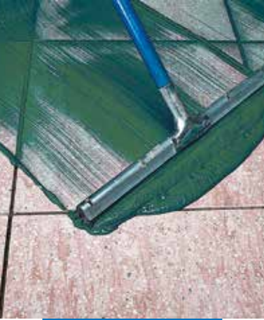
Nanošenje Ultracolor-a Plus na pod gumiranim brisačem
