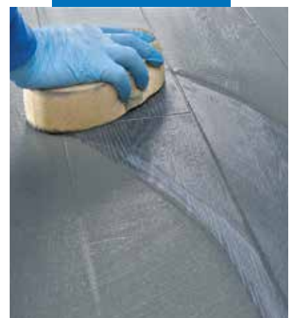
Čišćenje i završna obrada fuga tvrdom celuloznom spužvom
