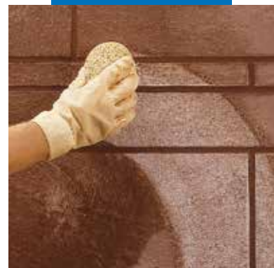
Čišćenje i završna obrada fuga spužvom
