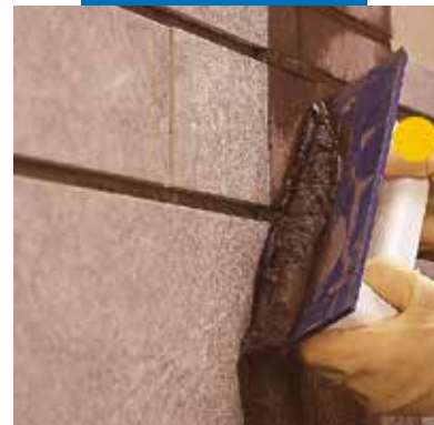
Nanošenje Ultracolor-a Plus na zid gumiranom gladilicom
