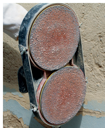
Uklanjanje stare žbuke
