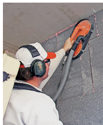
Brušenje EIFS i ETICS izolacijskih ploča
