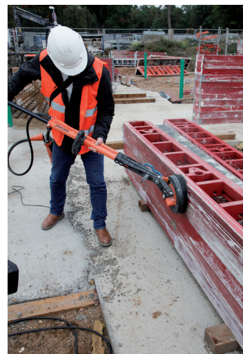
Čišćenje segmenata oplata u uspranom položaju
