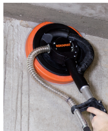
Brušenje betonskih neravnina
