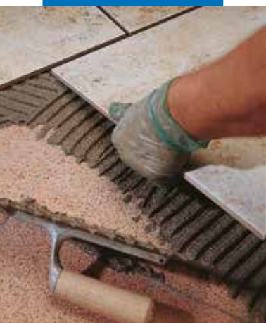
Polaganje jednom pečenih pločica na vanjski teraco pod
