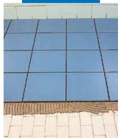
Polaganje keramičkih pločica na postojeću oblogu sivim ljepilom Keraflex
