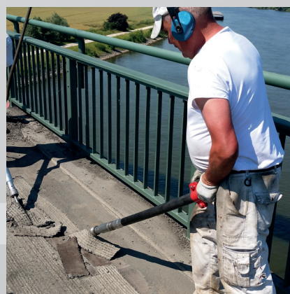
Uklanjanje premaza
