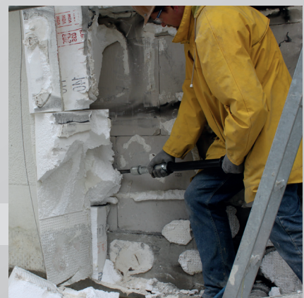
Uklanjanje izolacije
