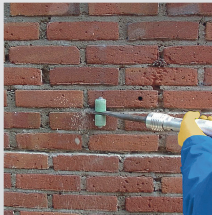
Čišćenje zidnih fuga
