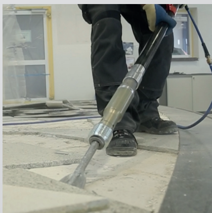
Opuštanje podnih pločica
