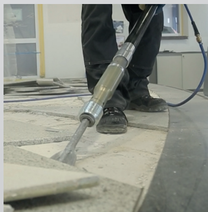
Labavljenje podnih pločica
