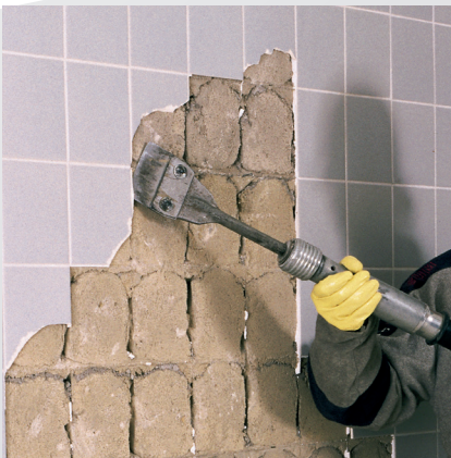
Uklanjanje zidnih pločica
