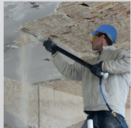
Uklanjanje stropne žbuke
