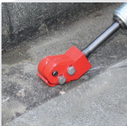
Rezanje bitumenske folije
