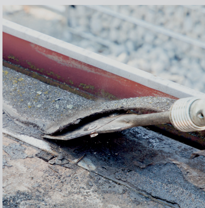
Opuštanje spojeva
