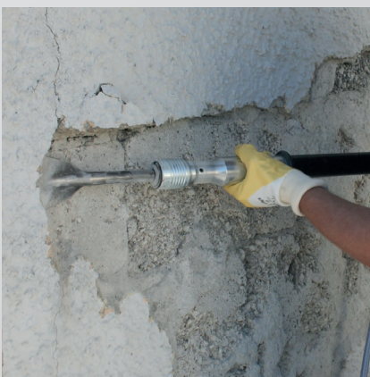
Uklanjanje vanjske žbuke
