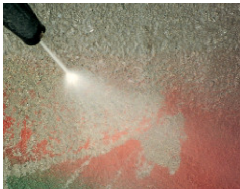
Korištenje visokotlačnog čistača na betonu tretiranom WallGard Graffiti Barrier-om
