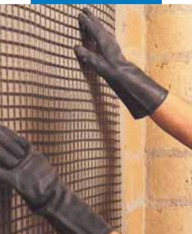
Postavljanje Mapegrid-a G 220
