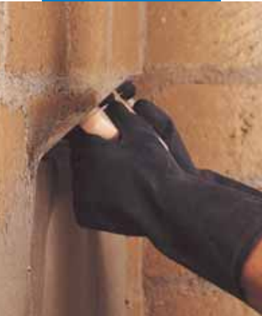
Nanošenje prvog sloja Planitop-a HDM
